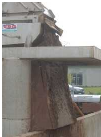
LE SÉPARATEUR DE PHASE À TAMIS RETRAITE LE DIGESTAT. LA PARTIE LIQUIDE EST ÉPANDUE SUR LES PARCELLES LES PLUS PROCHES. CETTE PRATIQUE A PERMIS D'ÉCONOMISER L'ACHAT D'ENGRAIS POUR PLUS DE 25 HA DE SURFACE AGRICOLE UTILE.
