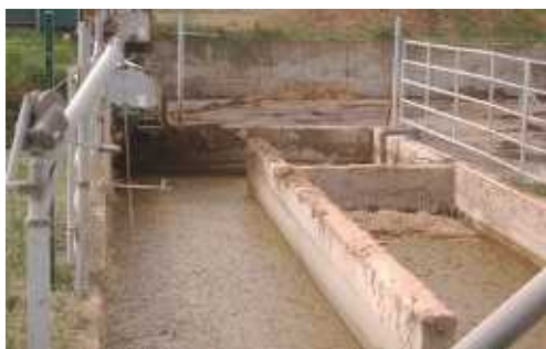
LA PRÉFOSSÉ PERMET D'HOMOGENÉISER LES DÉJECTIONS ANIMALES AVANT DE LES ENVOYER VERS L'UNITÉ DE MÉTHANISATION.
